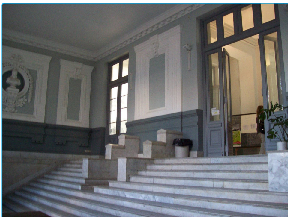
ACCESO RODÓ (DESPUÉS)
