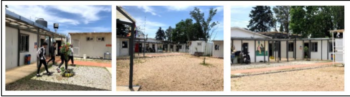
Figura 4. Imágenes del edificio existente. Fuente: ANEP.
