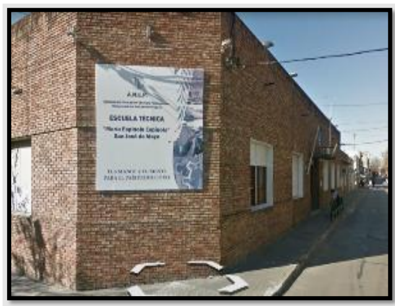
Figura 2. Edificio original de la Escuela Técnica San José, Departamento San José.
